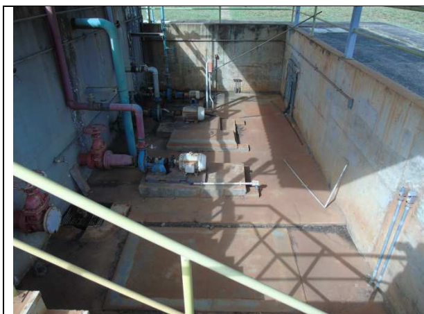
Detalhe do poço e bombas
