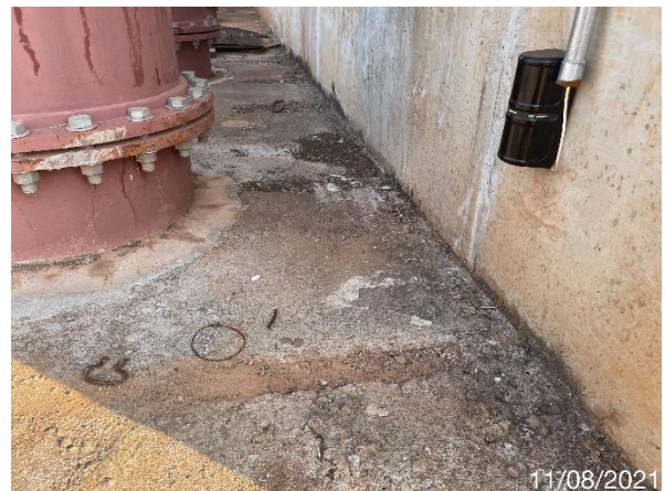
Foto 7.36: Concretagem da laje irregular (Data da imagem: 11/08/2021)
