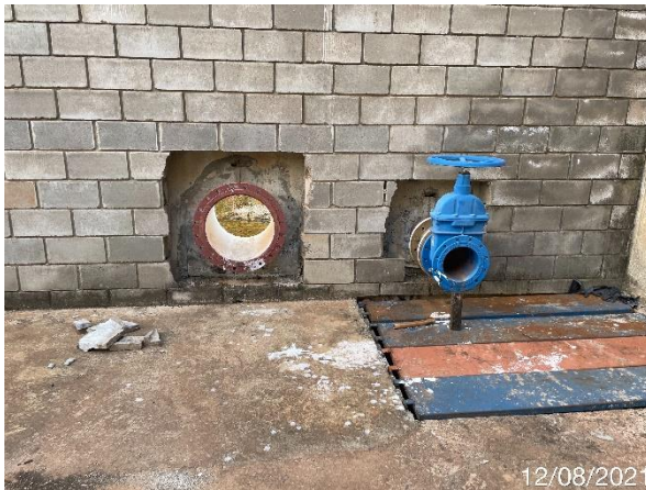
Foto 7.316: Estrutura sem acabamento e com ferragem exposta sem a proteção adequada (Data da imagem: 12/08/2021)
