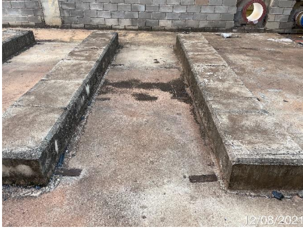
Foto 7.320: Presença de taliscas de madeira (Data da imagem: 12/08/2021)
