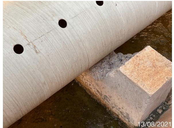
Foto 7.240: Estrutura do berço de apoio das tubulações sem acabamento. (Data da imagem: 13/08/2021)
