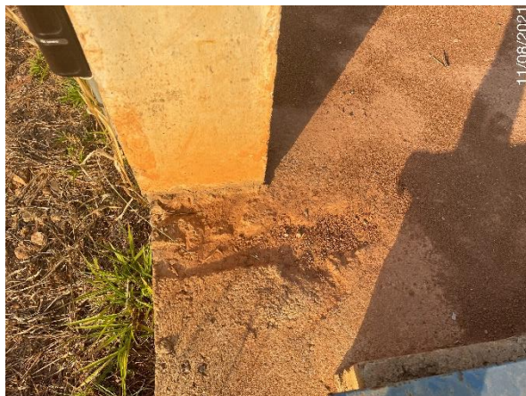
Foto 7.37: Concretagem da laje irregular (Data da imagem: 11/08/2021)
