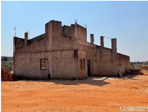
Foto 7.480: Aparência externa do edifício (Data da imagem: 12/08/2021)
