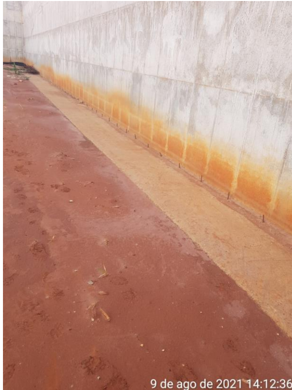
Foto 7.155: Marcas de formas na estrutura de concreto e com presença de ferragem na estrutura (Data da imagem: 09/08/2021)
