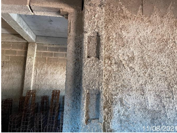
Foto 7.430: Serviços de chapisco incompletos (Data da imagem: 11/08/2021)
