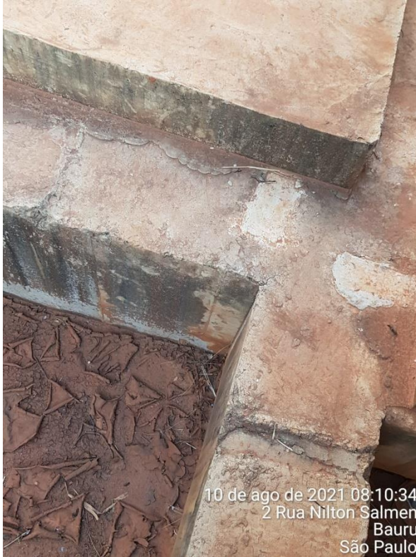
Foto 7.115: Superfície do concreto com irregularidades e marcas das formas (Data da imagem: 10/08/2021)
