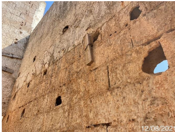
Foto 7.494: Blocos de concreto quebrado e presença de formas de madeira (Data da imagem: 12/08/2021)
