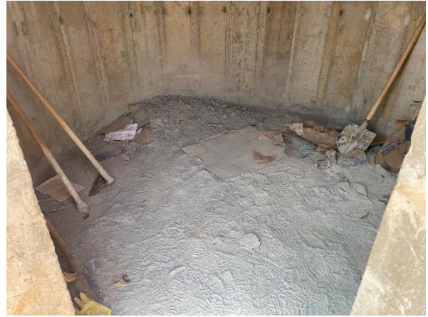
Foto 7.395: Aparência interna do reservatório (Data da imagem: 11/08/2021)
