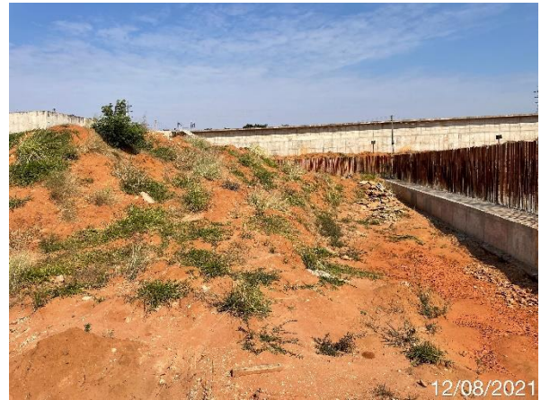
Foto 7.170: Presença de resíduos no interior do tanque (Data da imagem: 12/08/2021)
