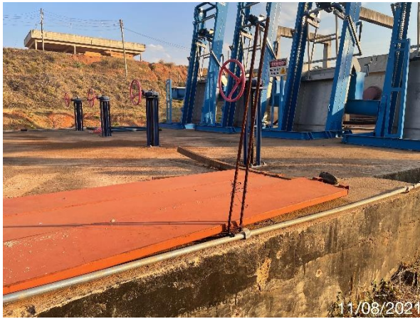
Foto 7.17: Canal de gradeamento (Data da imagem: 11/08/2021)
