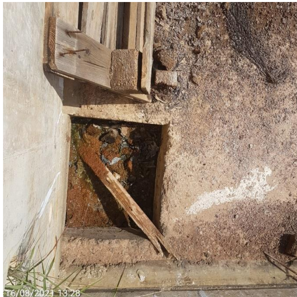
Foto 7.179: Ausência da tampa de fechamento e com resíduos da construção (Data da imagem: 16/08/2021)
