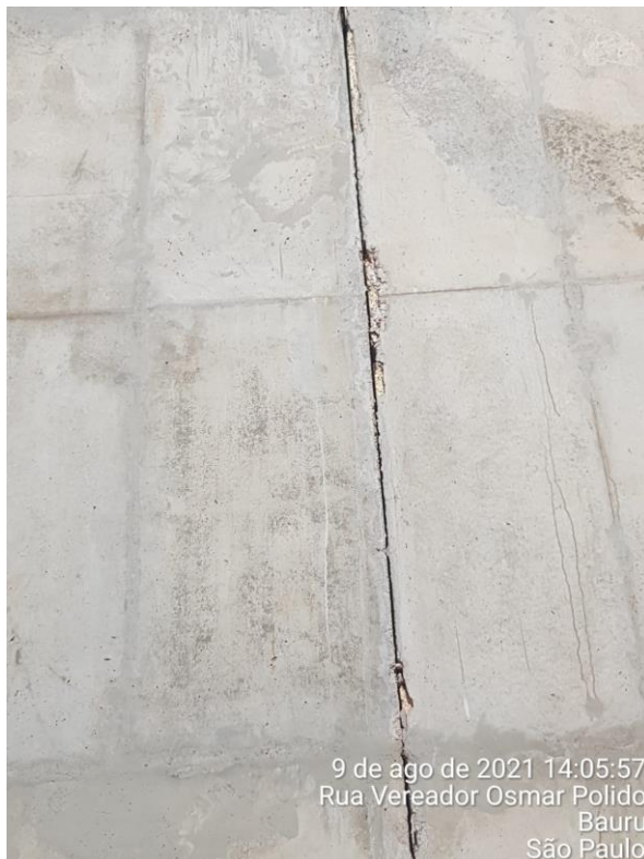
Foto 7.157: Marcas de formas na estrutura de concreto e irregularidades na face da estrutura (Data da imagem: 09/08/2021)
