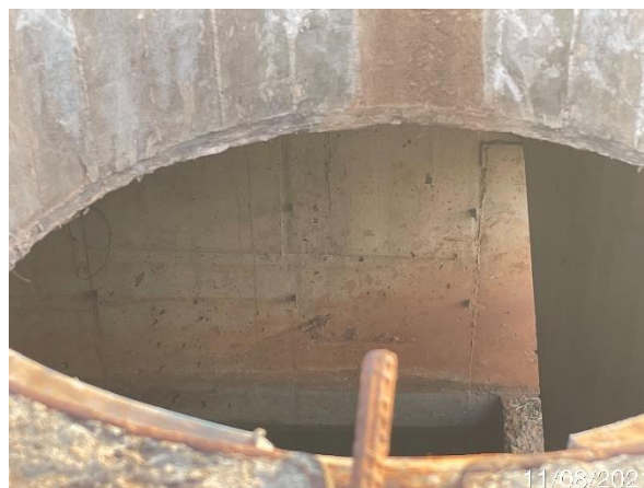
Foto 7.16: Aparência interna da Caixa de Entrada com marcas de formas e presença de núcleos perdidos (Data da imagem: 11/08/2021)
