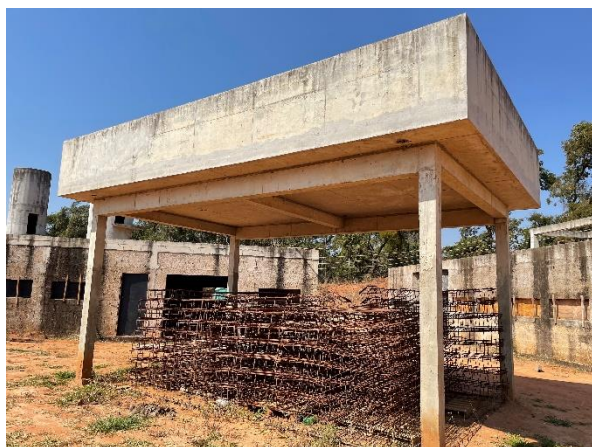
Foto 7.474: Aparência da subestação SE-10 (Data da imagem: 11/08/2021)
