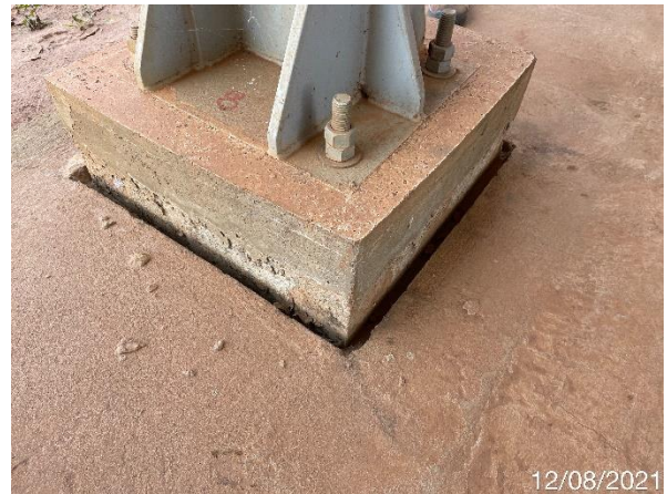
Foto 7.172: Acabamento dos blocos dos pilares (Data da imagem: 12/08/2021)
