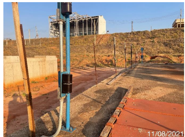
Foto 7.28: Presença de ferragens na laje (Data da imagem: 11/08/2021)
