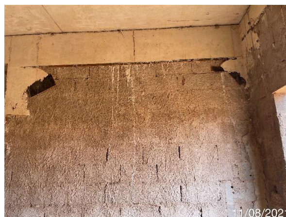
Foto 7.417: Formas de madeira nas vigas (Data da imagem: 11/08/2021)
