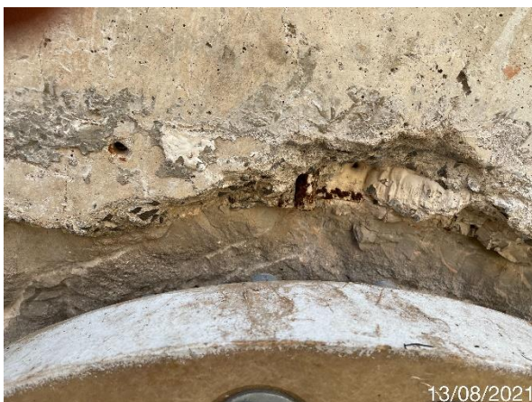
Foto 7.219: Estrutura sem acabamento (Data da imagem: 13/08/2021)
