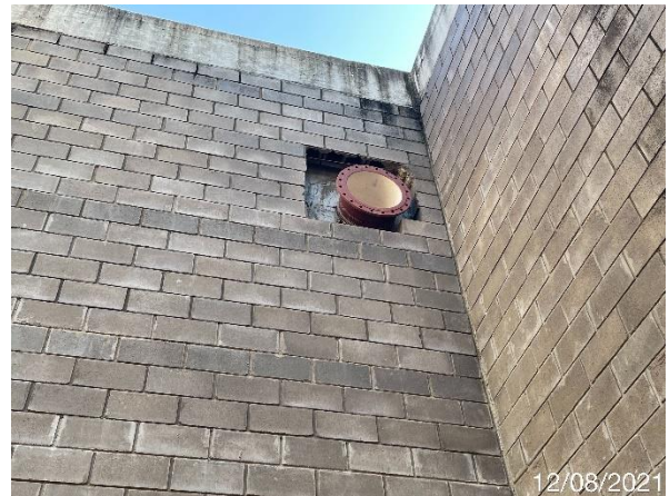
Foto 7.317: Estrutura sem acabamento. (Data da imagem: 12/08/2021)
