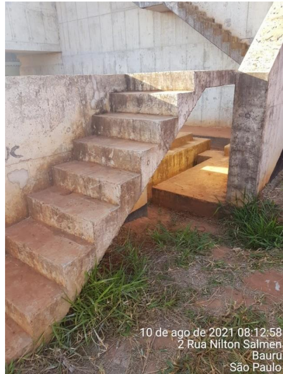
Foto 7.112: Superfície de concreto irregular, com marcas das formas e vazios de concretagem (Data da imagem: 10/08/2021)
