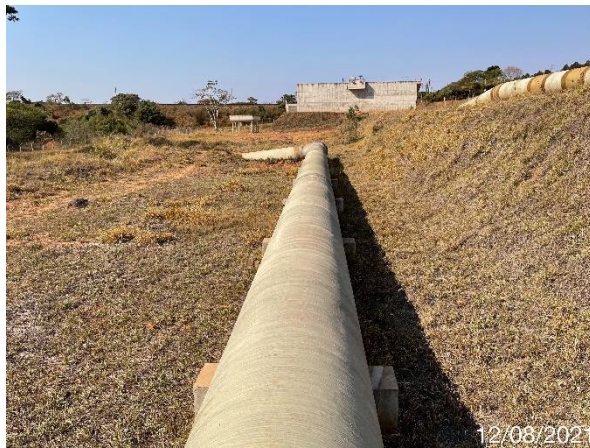
Foto 7.288: Aparência dos Suportes da tubulação de Ø1200 mm (Data da imagem: 12/08/2021)
