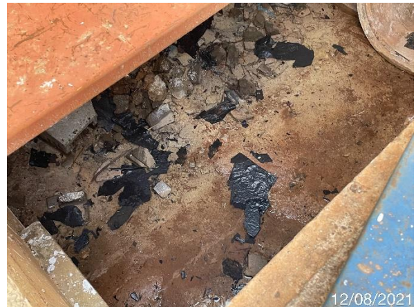
Foto 7.319: Presença de resíduos de construção (Data da imagem: 12/08/2021)
