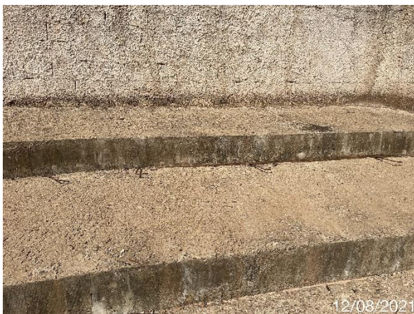
Foto 7.490: Presença de ferragem na arquibancada (Data da imagem: 12/08/2021)
