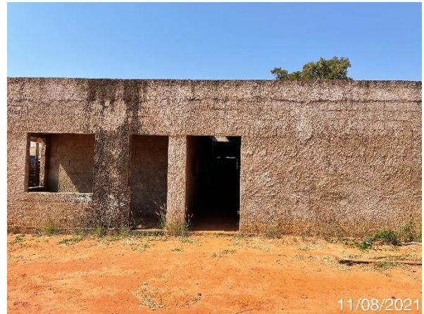
Foto 7.419: Aparência externa do edifício (Data da imagem: 11/08/2021)
