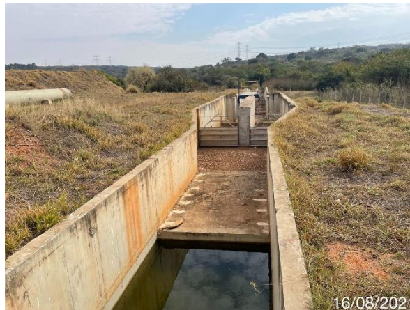
Foto 7.261: Aparência da Calha Parshall (Data da imagem: 12/08/2021)
