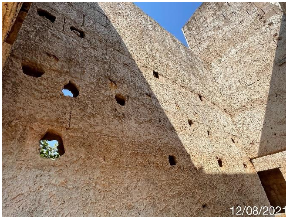
Foto 7.488: Blocos de concreto quebrados (Data da imagem: 12/08/2021)
