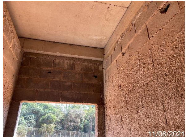
Foto 7.427: Serviços de chapisco incompletos (Data da imagem: 11/08/2021)
