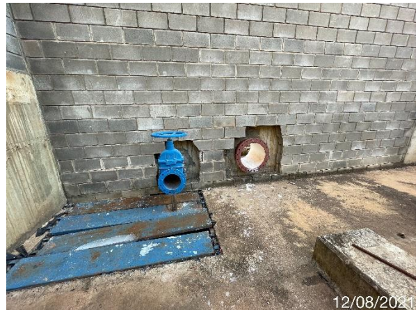
Foto 7.311: Estrutura sem acabamento. (Data da imagem: 12/08/2021)
