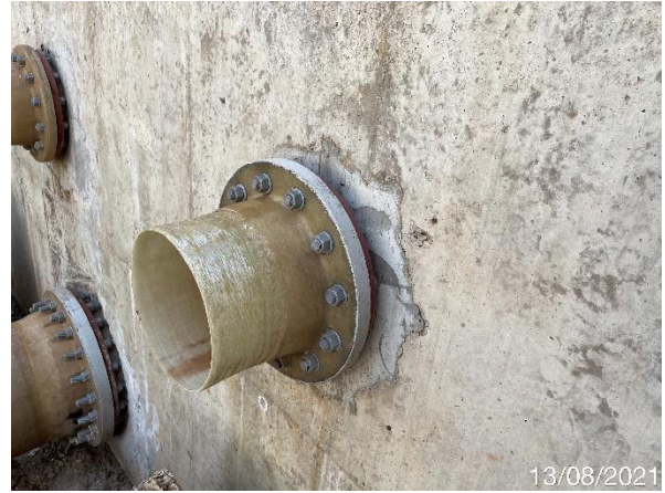
Foto 7.228: Extremidade com dimensões diferente do projeto (Data da imagem: 12/08/2021)
