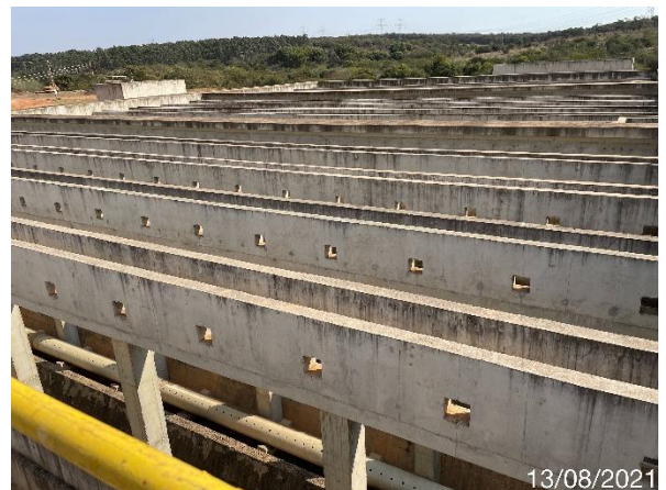
Foto 7.244: Aparência interna do Decantador (Data da imagem: 13/08/2021)
