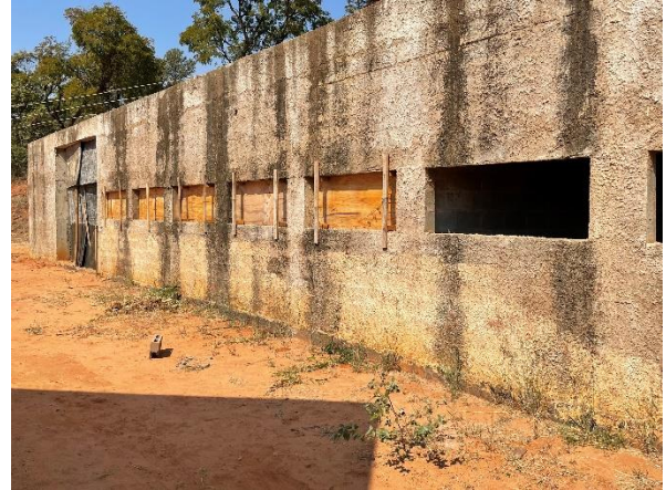
Foto 7.425: Aparência externa do edifício (Data da imagem: 11/08/2021)
