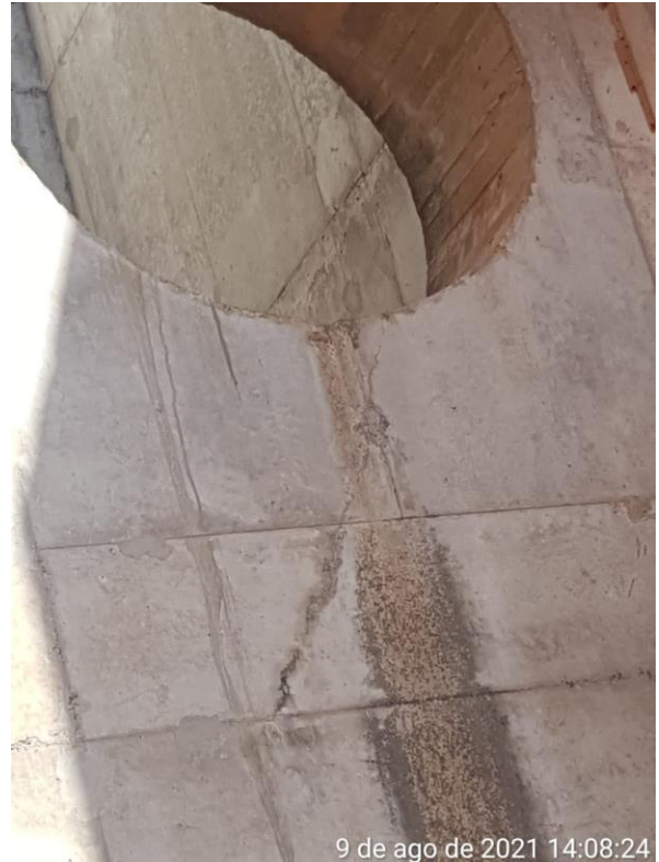
Foto 7.156: Marcas de formas na estrutura de concreto, com irregularidades na estrutura e presença de fissuras e vazios de concreto (Data da imagem: 09/08/2021)
