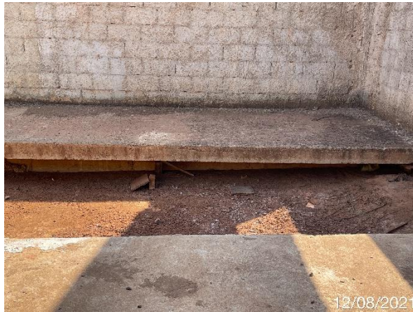
Foto 7.492: Laje da arquibancada (Data da imagem: 12/08/2021)
