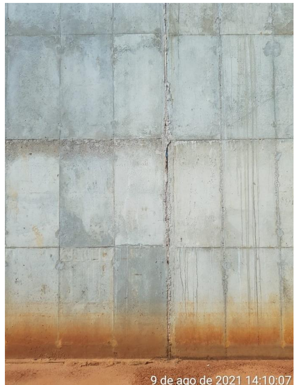
Foto 7.158: Marcas de formas na estrutura de concreto e com presença de ferragem (Data da imagem: 09/08/2021)
