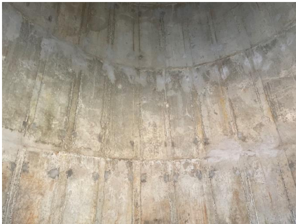
Foto 7.396: Marcas de formas no concreto (execução com forma inadequada) (Data da imagem: 11/08/2021)
