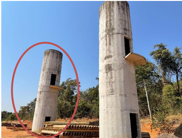
Foto 7.398: Aparência externa do reservatório (Data da imagem: 11/08/2021)
