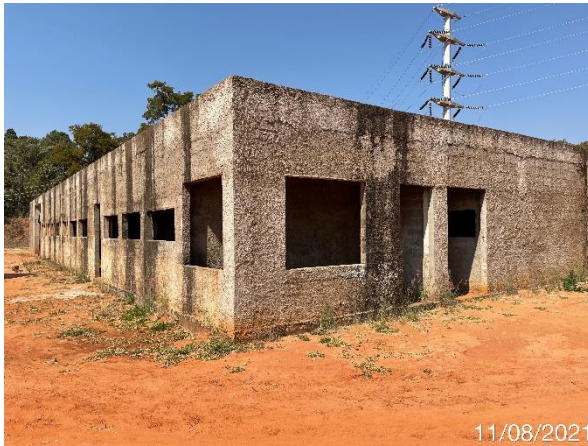
Foto 7.418: Aparência externa do edifício (Data da imagem: 11/08/2021)
