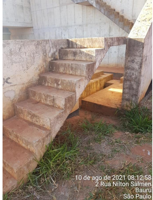
Foto 7.116: Superfície de concreto irregular, marcas das formas e vazios de concretagem (Data da imagem: 10/08/2021)
