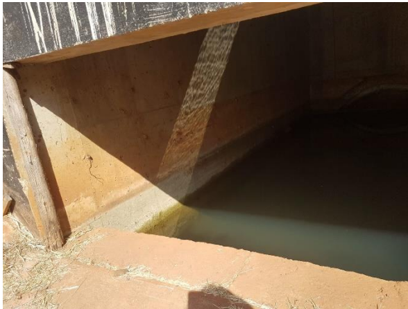
Foto 7.496: Presença de água no canal do extravasor (Data da imagem: 11/08/2021)
