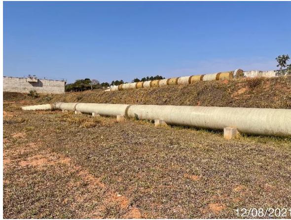
Foto 7.286: Aparência dos Suportes da tubulação de Ø1200 mm (Data da imagem: 12/08/2021)
