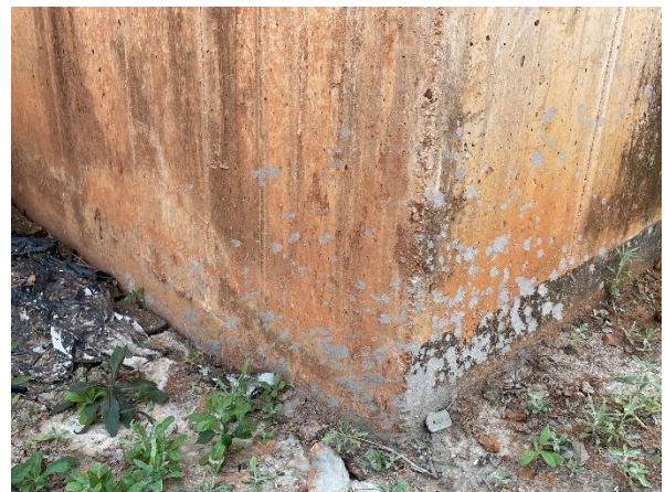
Foto 7.68: Ausência de impermeabilização betuminosa e superfície de concreto danificada (Data da imagem: 11/08/2021)
