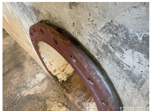
Foto 7.196: Extremidade com dimensões diferentes do projeto (Data da imagem: 12/08/2021)
