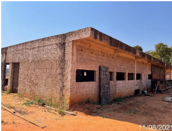
Foto 7.420: Aparência externa do edifício (Data da imagem: 11/08/2021)
