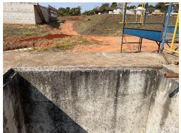
Foto 7.250: Presença de forma de madeira (Data da imagem: 13/08/2021)
