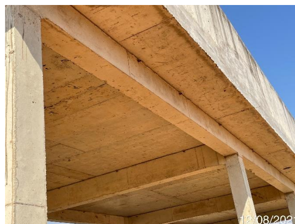
Foto 7.463: Marcas de forma no concreto, presença de núcleos perdidos e vazios de concretagem (Data da imagem: 12/08/2021)
