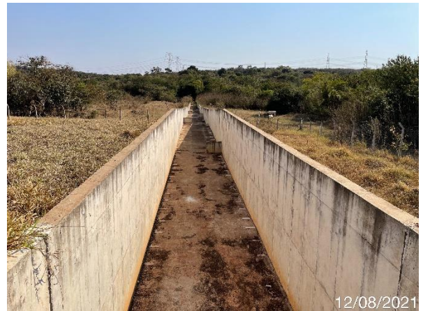
Foto 7.263: Aparência do canal da Escada Hidráulica (Data da imagem: 12/08/2021)
