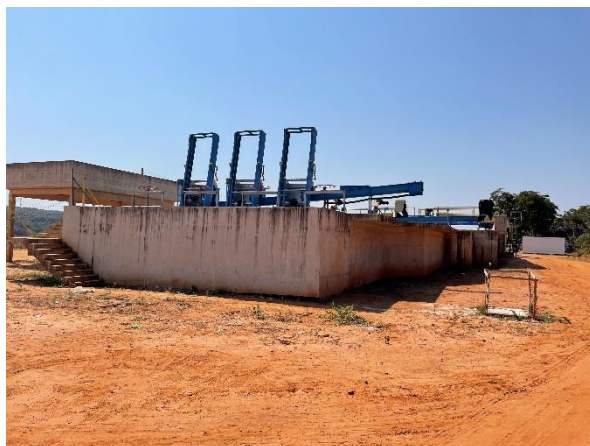
Foto 7.77: Aparência externa do Tratamento Preliminar Face Oeste (Data da imagem: 11/08/2021)
