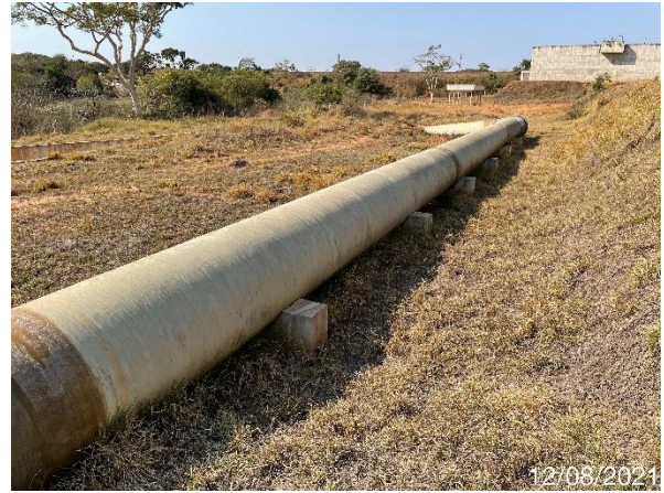
Foto 7.287: Aparência dos Suportes da tubulação de Ø1200 mm (Data da imagem: 12/08/2021)
