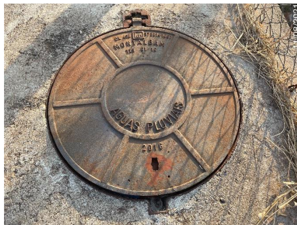
Foto 7.14: Reparos na tampa de fechamento e alteração da descrição para esgoto (Data da imagem: 11/08/2021)
