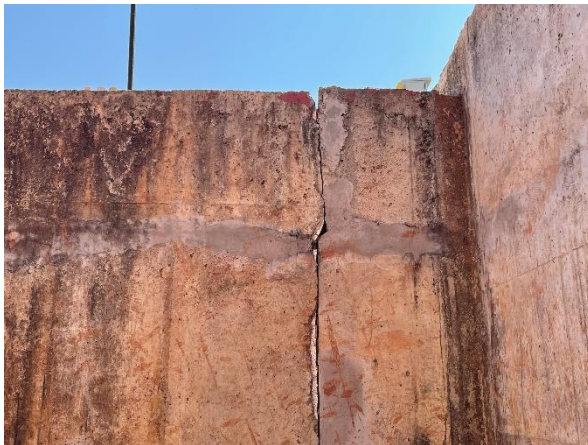
Foto 7.65: Superfície do concreto na junta de dilatação (Data da imagem: 11/08/2021)
