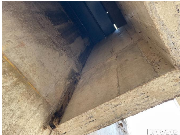
Foto 7.211: Presença de núcleos perdidos (Data da imagem: 13/08/2021)
