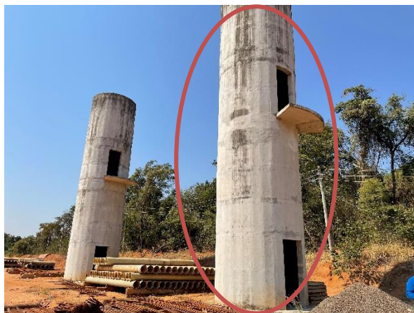
Foto 7.392: Aparência externa do reservatório (Data da imagem: 11/08/2021)
