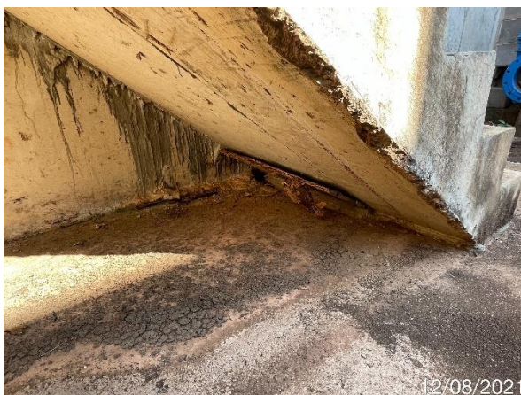
Foto 7.368: Presença de formas de madeira (Data da imagem: 12/08/2021)
