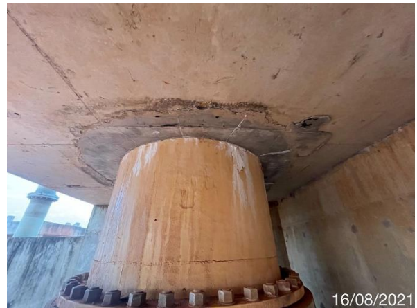
Foto 7.118: Superfície de concreto irregular, marcas das formas e vazios de concretagem (Data da imagem: 16/08/2021)
