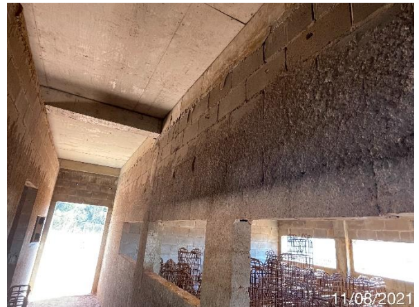
Foto 7.433: Serviços de chapisco incompletos (Data da imagem: 11/08/2021)
